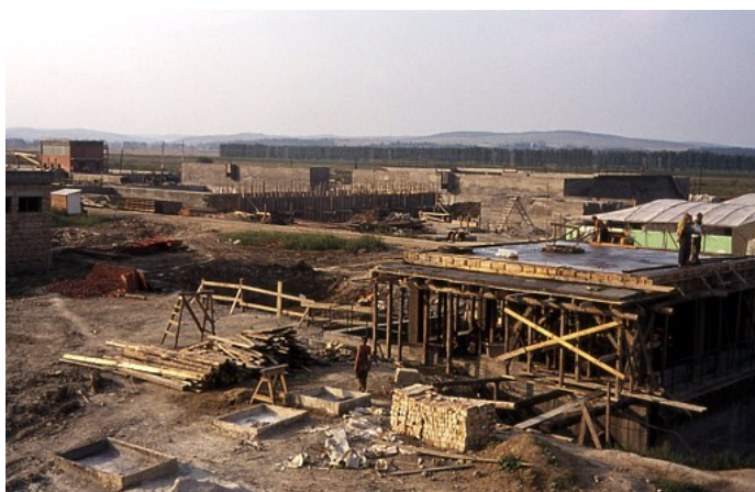
Rensningsanlægget Sajó-part under opførelse
