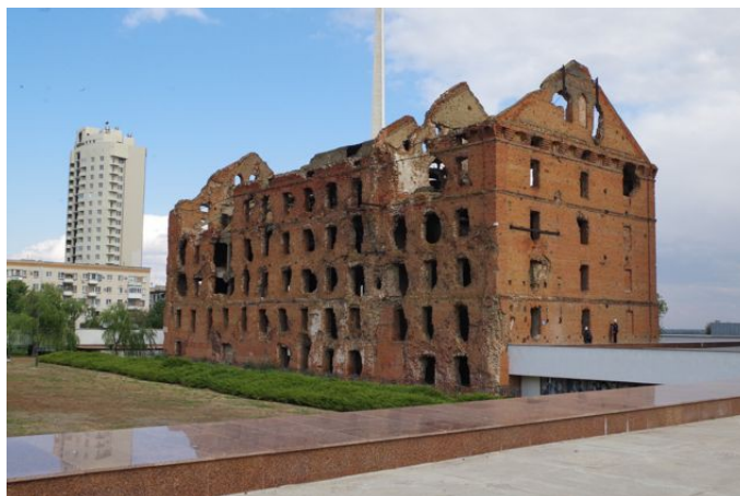
Det eneste hus i Volgograd fra før 1943
